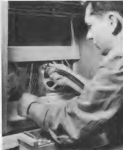
Bild 1. Ein Druckluftschauber bei der Lautsprechermontage
