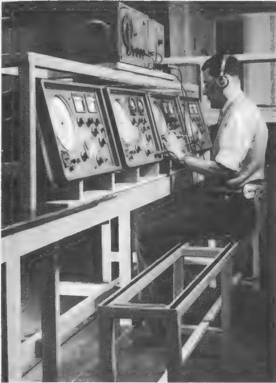
Arbeitsstudien in der St.-Albans-Fabrik von Marconi Instruments Ltd. haben zu dieser wirksameren Anordnung geführt, um vier Frequenzgeneratoren gleichzeitig eichen zu können. Das Prüfgerät ist auf einem Schiebegerüst angebracht. Der Techniker sitzt auf einem Gleitsitz, und die Frequenzgeneratoren sind so geneigt, daß die Bedienungsschalter leicht zugänglich sind
